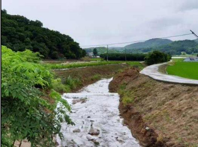
토사를 긁어내어 정비된 농수로와 농수로 구석에 쌓아놓은 토사.
